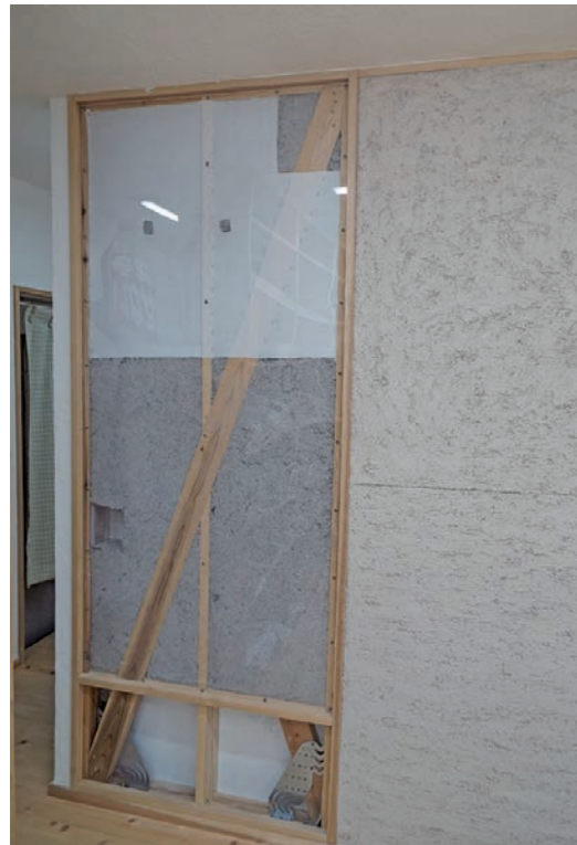
セルローズファイバーの充填の様子
