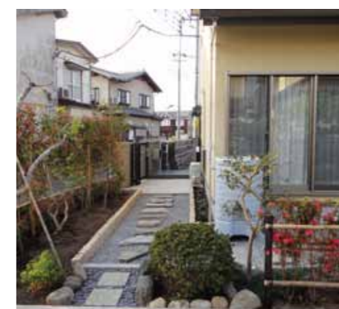
雨水タンク設置例
