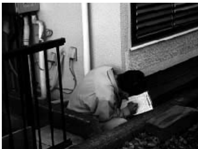
基礎回り点検
