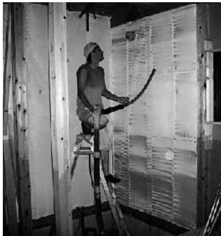
▲断熱吹き込み作業
