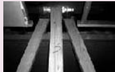
▲壁耐震補強…筋交いと耐震パネルの取り付け
