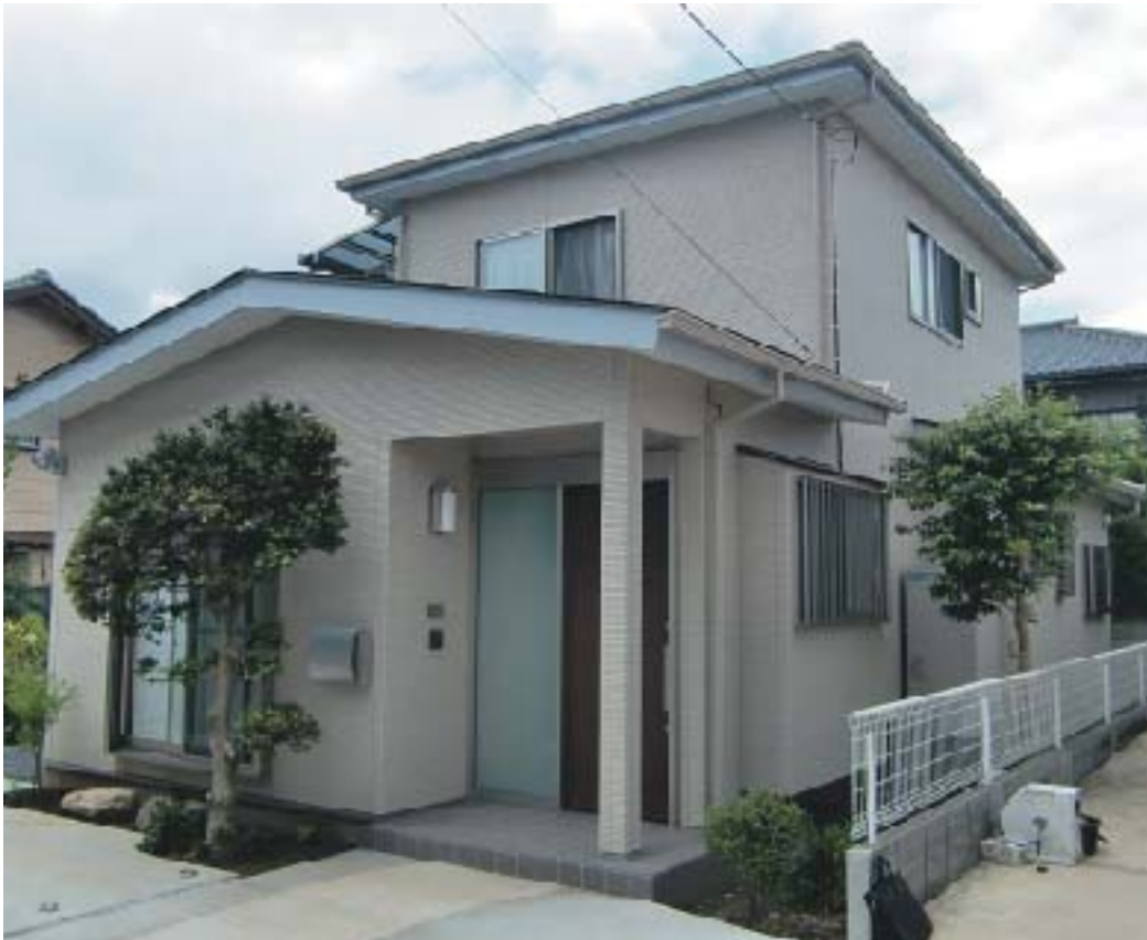
▲完成した建物外観
