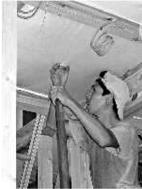
セルローズファイバー天井シート貼り吹込工事
