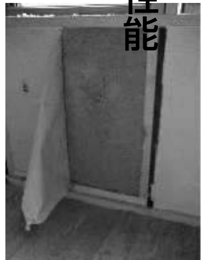
セルローズファイバー外壁の吹込状態
