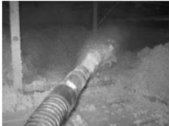
セルローズファイバー小屋裏吹込工事
