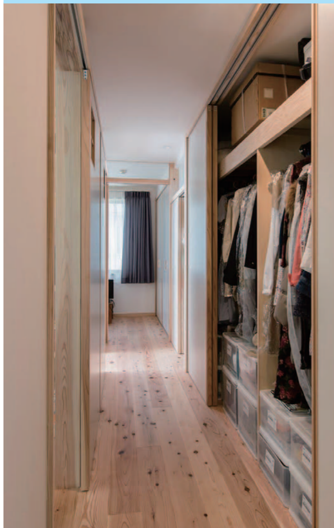
③造り付けの衣類収納。引き戸なので、地震時にも安心。
