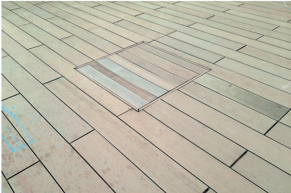
穴や段差のあるウッドデッキの補修
