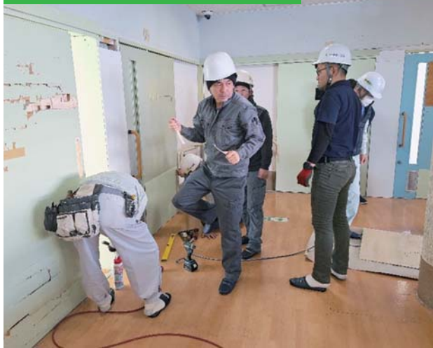
傷みが激しく動かない扉の開閉を確認
