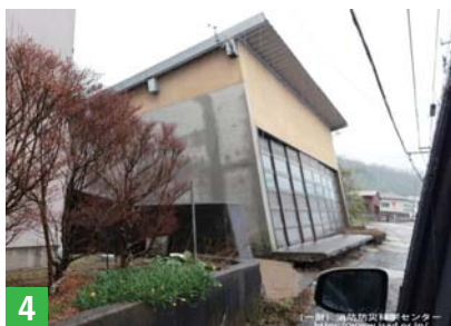
①1階部分が斜めに傾いた住宅 ②亀裂の入った地面のアスファルト ③建物危険判定「倒壊注意・立入禁止」 ④大きく傾いた建物 ⑤敷地と道路の間に大きな段差ができた住宅
